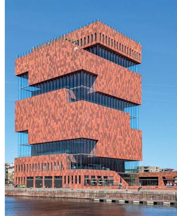
Il Museo aan de Stroom di Anversa – realizzato in arenaria rossa indiana e pannelli in vetro ricurvi – è tra gli edifici europei contemporanei più rilevanti. Alto sessanta metri celebra lo storico rapporto della città con il suo porto e la navigazione
