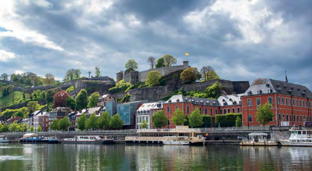
La Cittadella vista dalle acque sembra quasi invisibile. Si tratta infatti di un edificio militare, concepito dai romani e più volte ricostruito, dove buona parte degli spazi si trovano interrati, per resistere meglio agli attacchi degli assediati
