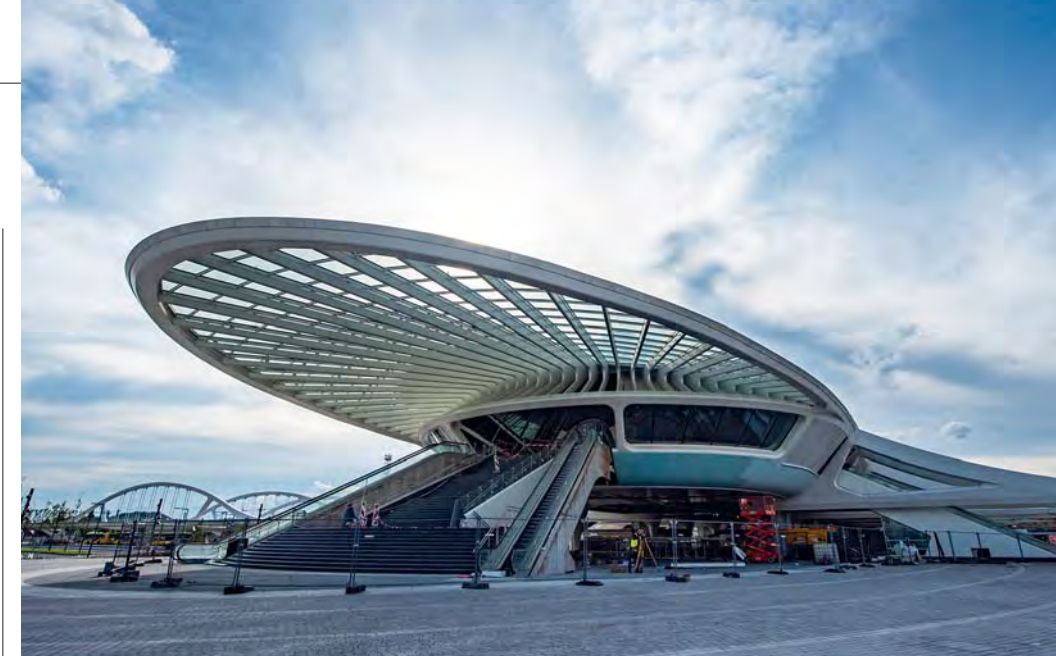
Tra qualche anno verrà completato questo gioiello: la nuova stazione firmata Calatrava. Com'è nel suo stile, il grande architetto spagnolo si è ispirato a forme oniriche collegate ad animali mitologici. L'edificio è la più evidente dimostrazione di come Mons guardi al futuro
