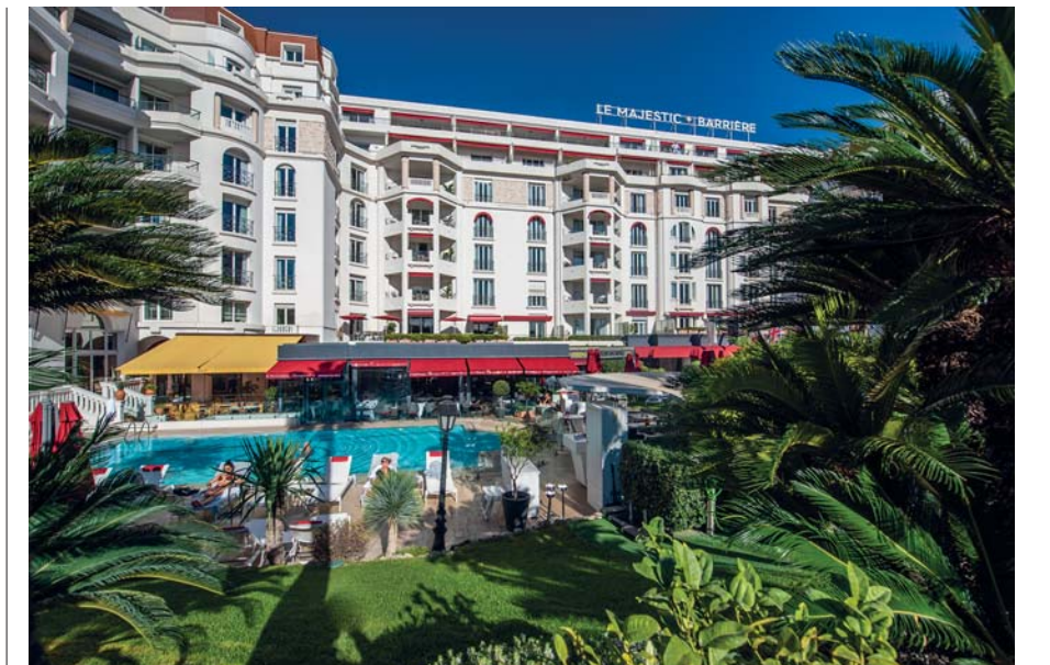
L'Hotel Barrière Le Majestic di Cannes, un mito della Costa Azzurra, concepito da Henry Ruhl e inaugurato nel 1926. La sua facciata appare dietro il parco che circonda la piscina, riscaldata durante tutto l'anno
